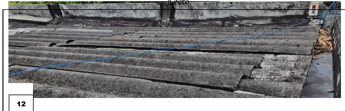
Figura 12 – Superfície de CE – de AFC – com declinação muito próxima – senão igual a zero.
