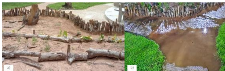
Figura 1: a) barreiras de troncos em contorno em área degradada. b) redução da erosão laminar após prática mecânica.
