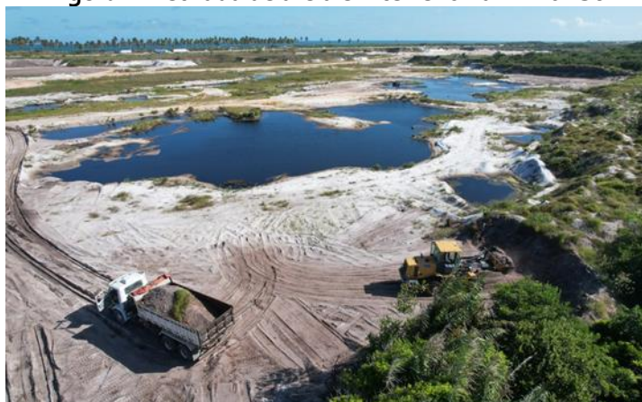
Figura 1. Retirada de areia em terreno na AL-101 Sul
